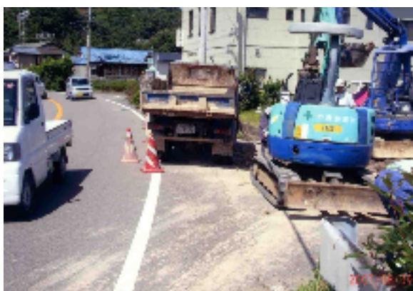
【写真：水道工事（生見）】
