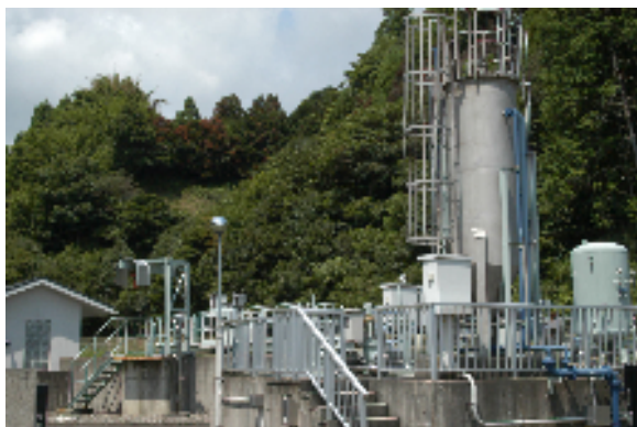
【写真：甲浦浄化センター（甲浦）】
